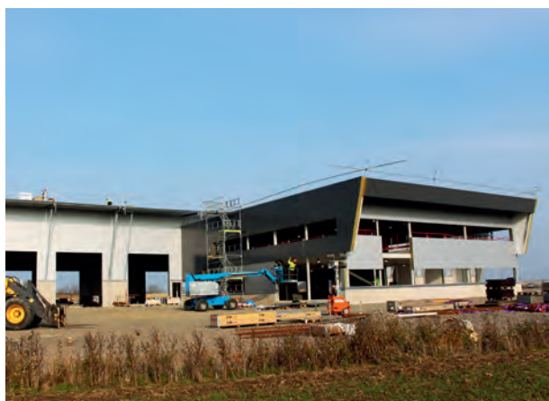
Pågående byggnation av modern lastvagnsanläggning i Ängelholm för Finnvedens Lastvagnar.
